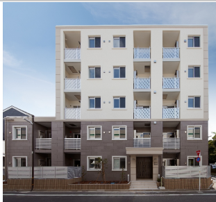
外断熱工法 Park side 次郎館（目黒区有明）
