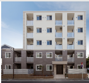
外断熱工法 Park side 次郎館（目黒緑有物件）
