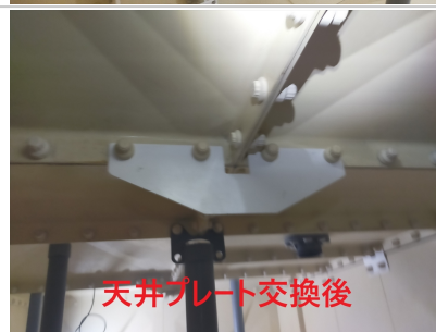
中仕切補強材交換後
