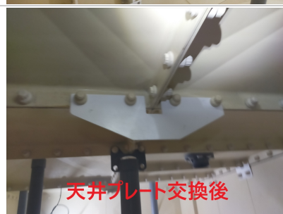
中仕切補強材交換後
